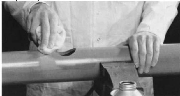
4. Наденьте на трубу два зажимных кольца с червячным приводом (Jubilee) которые прижмут опору к трубе опору во время схватывания клея. Зажимные кольца должны быть помещены по обе стороны седлового отвода. Нанесите растворитель на трубу и отвод. **Очень важно быстро наносить растворитель.**
