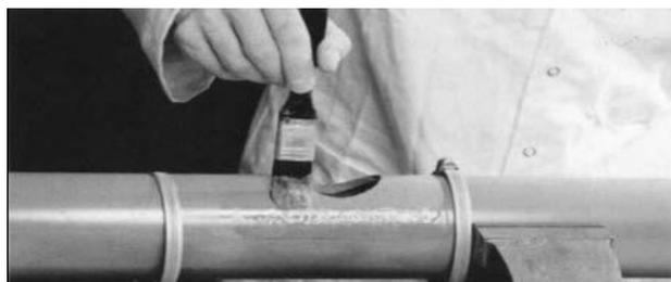
5. Установите опору на трубу, убедившись, что охватываемая деталь помещается в отверстие. Немедленно закрепите её на месте, используя зажимы с червячным приводе.
