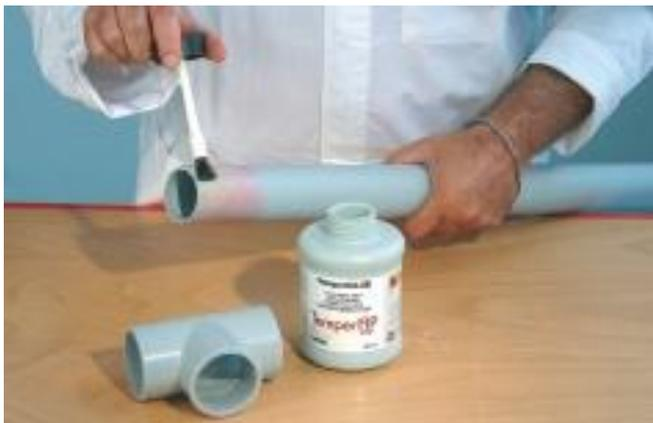
6. Плотно вставьте трубу в фитинг непосредственно после нанесения растворителя. Не перекручивайте. Подержите трубу и фитинг в руках несколько секунд: для труб размером от ¾" или 16мм и до 1 минуты для труб размером 8" или 225мм и выше. Правильное нанесение необходимого количества клея создаст аккуратную кромку раствора по краю фитинга и трубы. При работе в низких температурах, убедитесь, что на местах соединения отсутствует влага и лёд.
